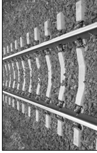
軌道のPCマクラギ化
